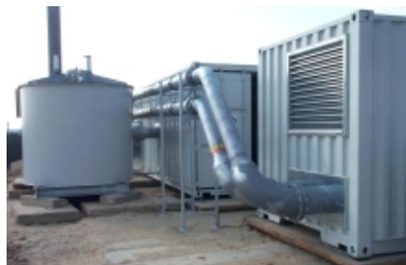
**Niederdruckbelüftung „Aeroflott“<sup>®</sup> zur beschleunigten aeroben in situ Stabilisierung:
